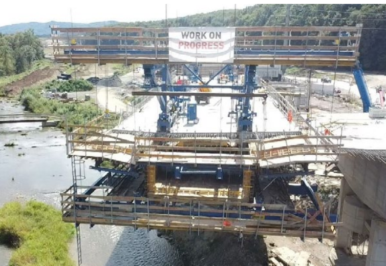
Fot. Wleloformatowa siatka mesh na elementach konstrukcji estakady, S19 Miejsce Piastowe — Dukla. © STRABAG
