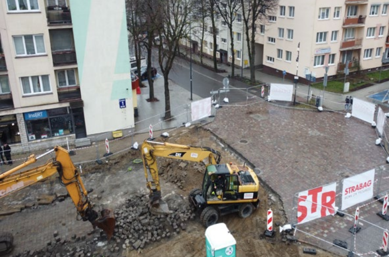
Fot: Prowadzone równoległe prace w różnych branżach. © STRABAG
