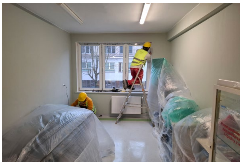
Fot. Prace przy wymianie stolarki okiennej. © STRABAG
