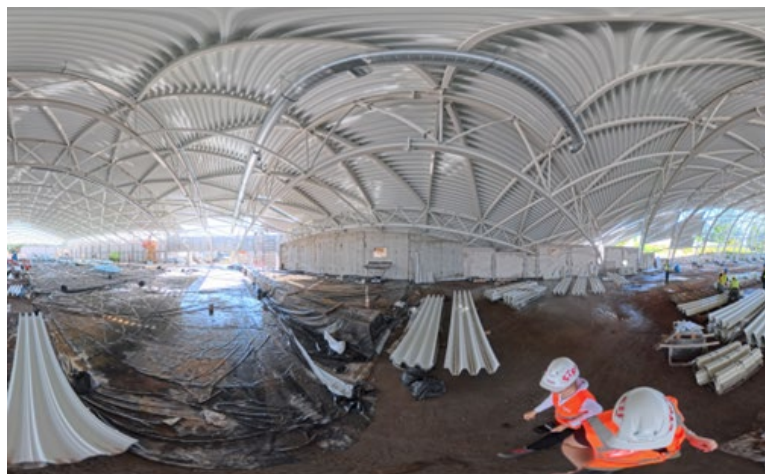
Fot. zdjęcie 360° płaskie na budowie hali sportowej w Bydgoszczy. © STRABAG
