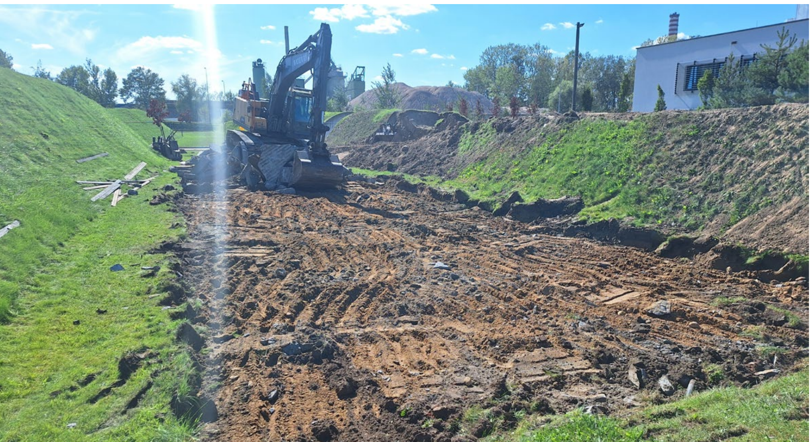
Fot. Trwające prace ziemne na terenie STRABAG HAUS w Pruszkowie. © STRABAG
